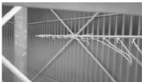
شکل ۱۹ الگوی جریان هوا در محل ۴ دلتای نامناسب
