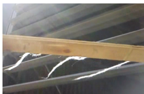
شکل ۱۶ الگوی جریان هوا در محل ۱ دلتای نامناسب
