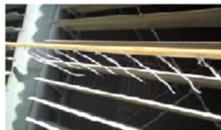
شکل ۱۱ الگوی جریان هوا در محل ۱ دلتای مناسب
