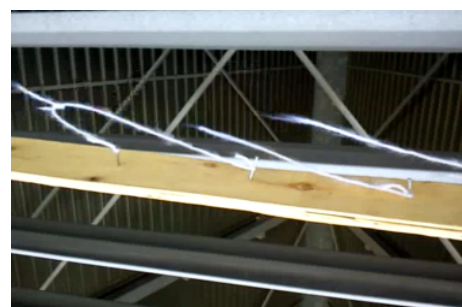
شکل ۱۷ الگوی جریان هوا در محل ۲ دلتای نامناسب
