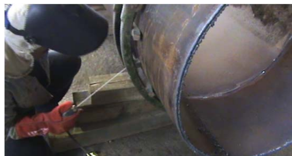
شکل (۱) جوشکاری سربه‌سر لوله
