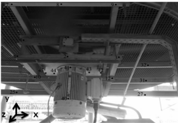
شکل 2 تصویر فن هوایی به همراه نقاط اندازه گیری
