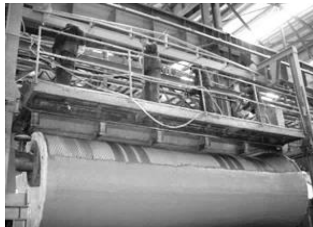
Fig. 6 The pouring of mortar
