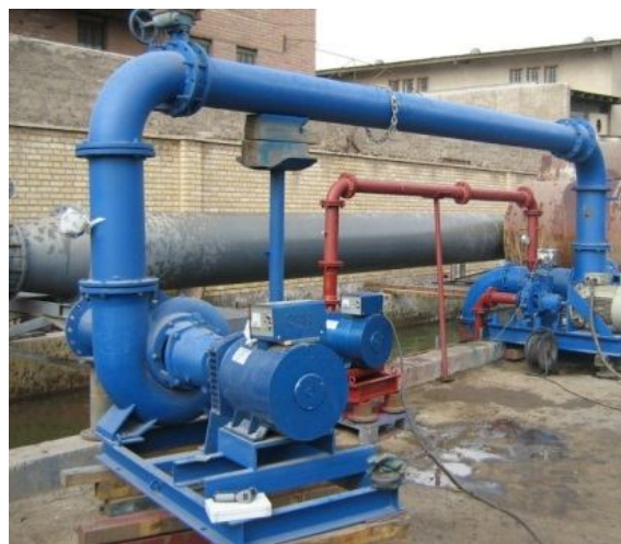
شکل ۲ مدار تست میکرو نیروگاه با نوربین نوع پلتون
