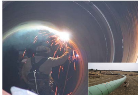
شکل ۱ جوش کاری داخل یک لوله نازک [۹،۸]
