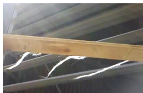
شکل ۱۶ الگوی جریان هوا در محل ۱ دلتای نامناسب
