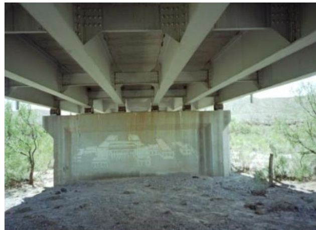
شکل 12 زیر سازه پل دره آلاموسا
