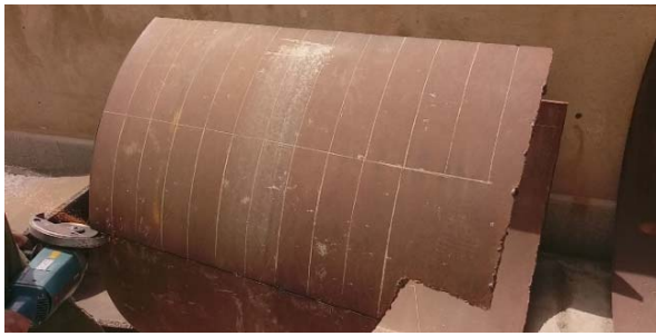
شکل ۴) خطکشی و برش اولیه لوله
