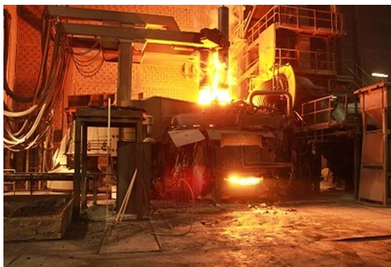
شکل ۱) کوره قوس الکتریکی مجتمع صنعتی فولاد اسفراین
