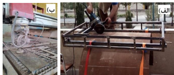
شکل ۳) الف) برش لوله فولادی به وسیله سنگ فرز. ب) عملیات واترجت صفحه اولیه توسط دستگاه واترجت.
