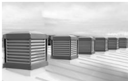
ب- استفاده از بادگیرها برای تهویه ساختمان‌های مدرن
