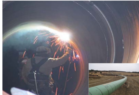
شکل ۳ جوش کاری داخل یک لوله نازک [۹،۸]
